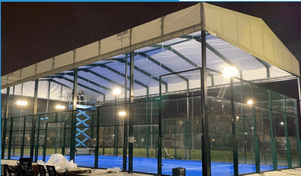
TENSOSTRUTTURA IN FERRO
